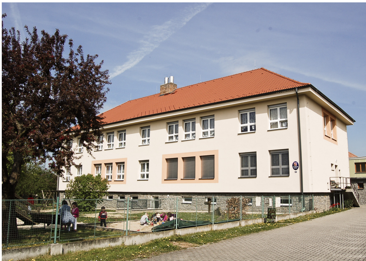
Sepekov - zateplení budovy MŠ
