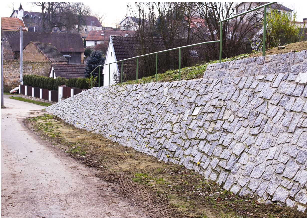
Jickovice - opěrná zed'
