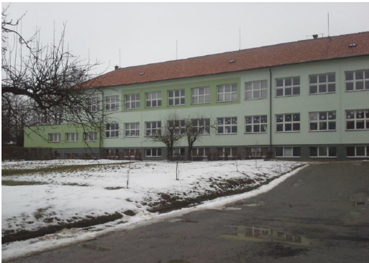
Sepekov - zateplení budovy ZŠ
