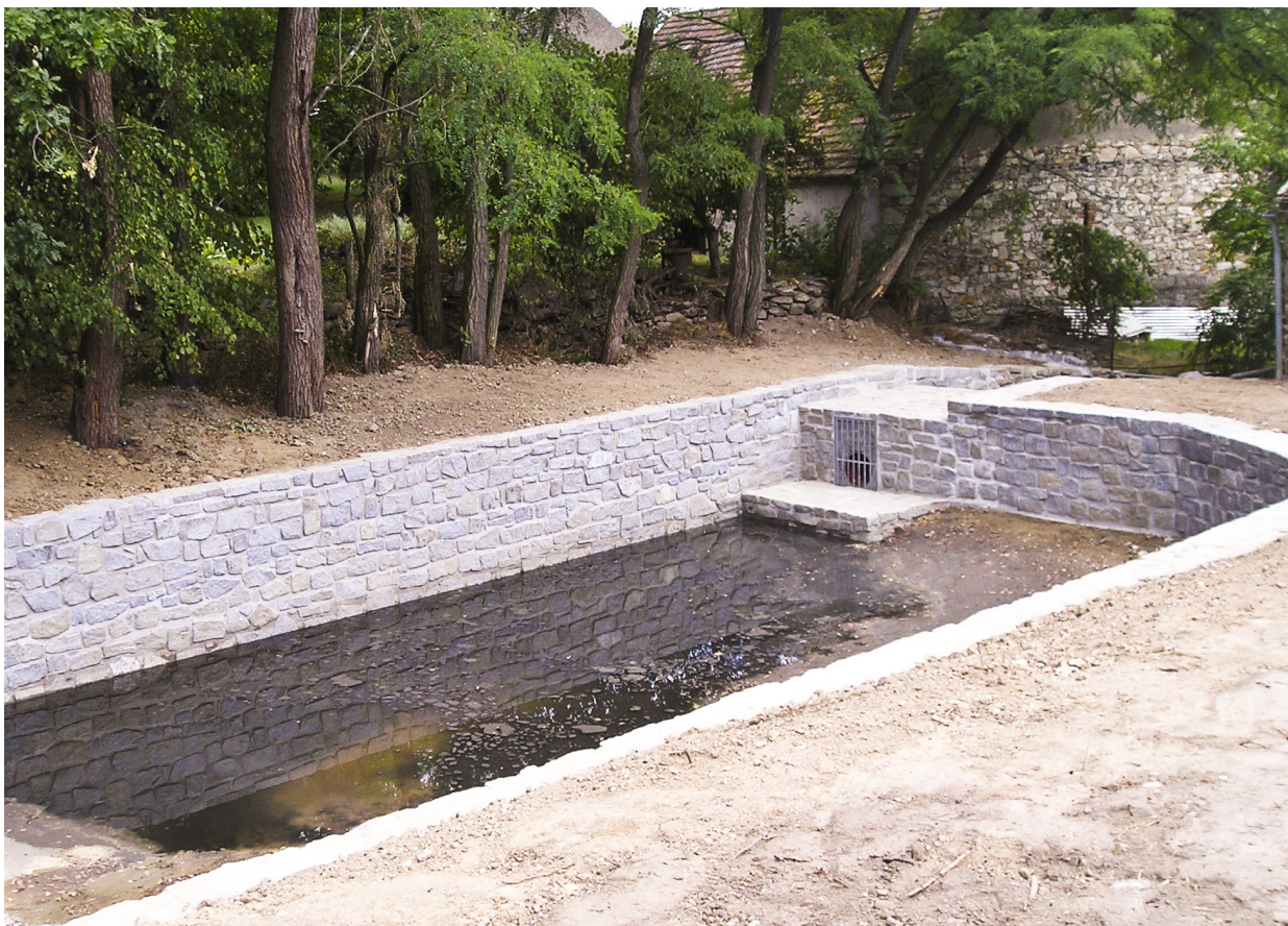
Štěkeň - retenční nádrž a kanalizace
