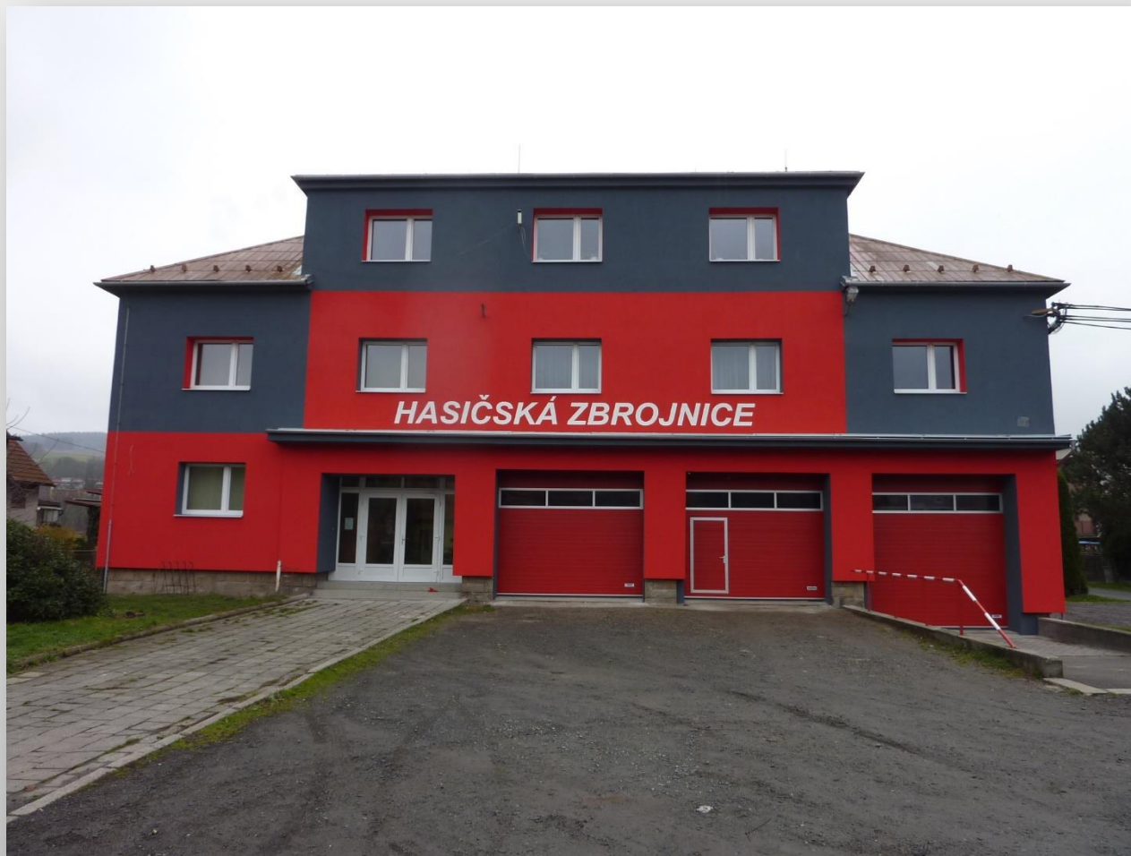
Rekonstrukce OD – HZS Jablůnka
