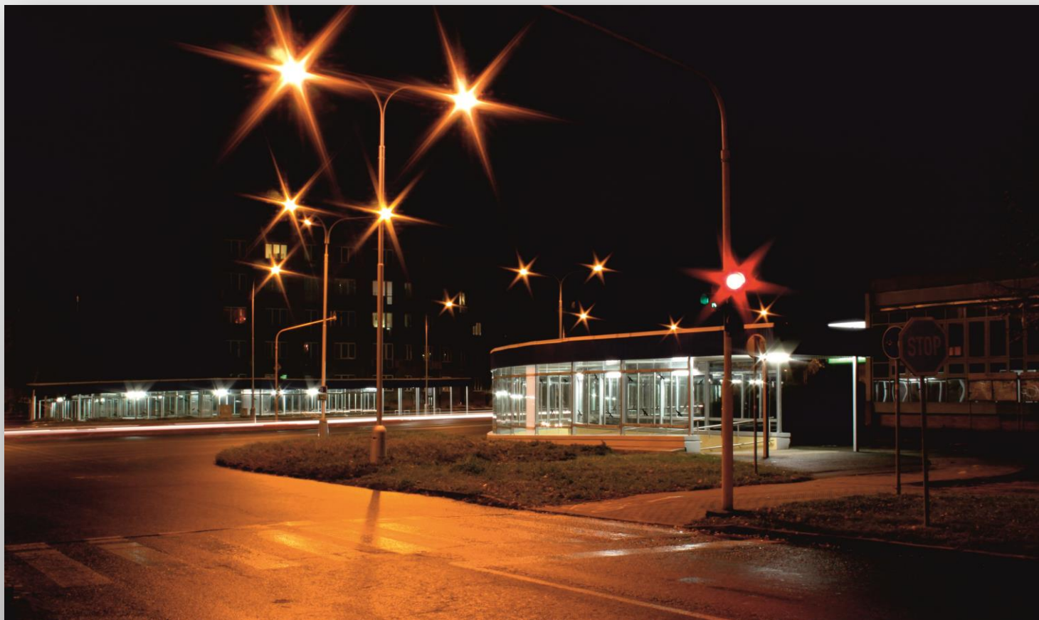
Rekonstrukce a oprava podchodu pod vozovkou ulice Foerstrova, město Olomouc
