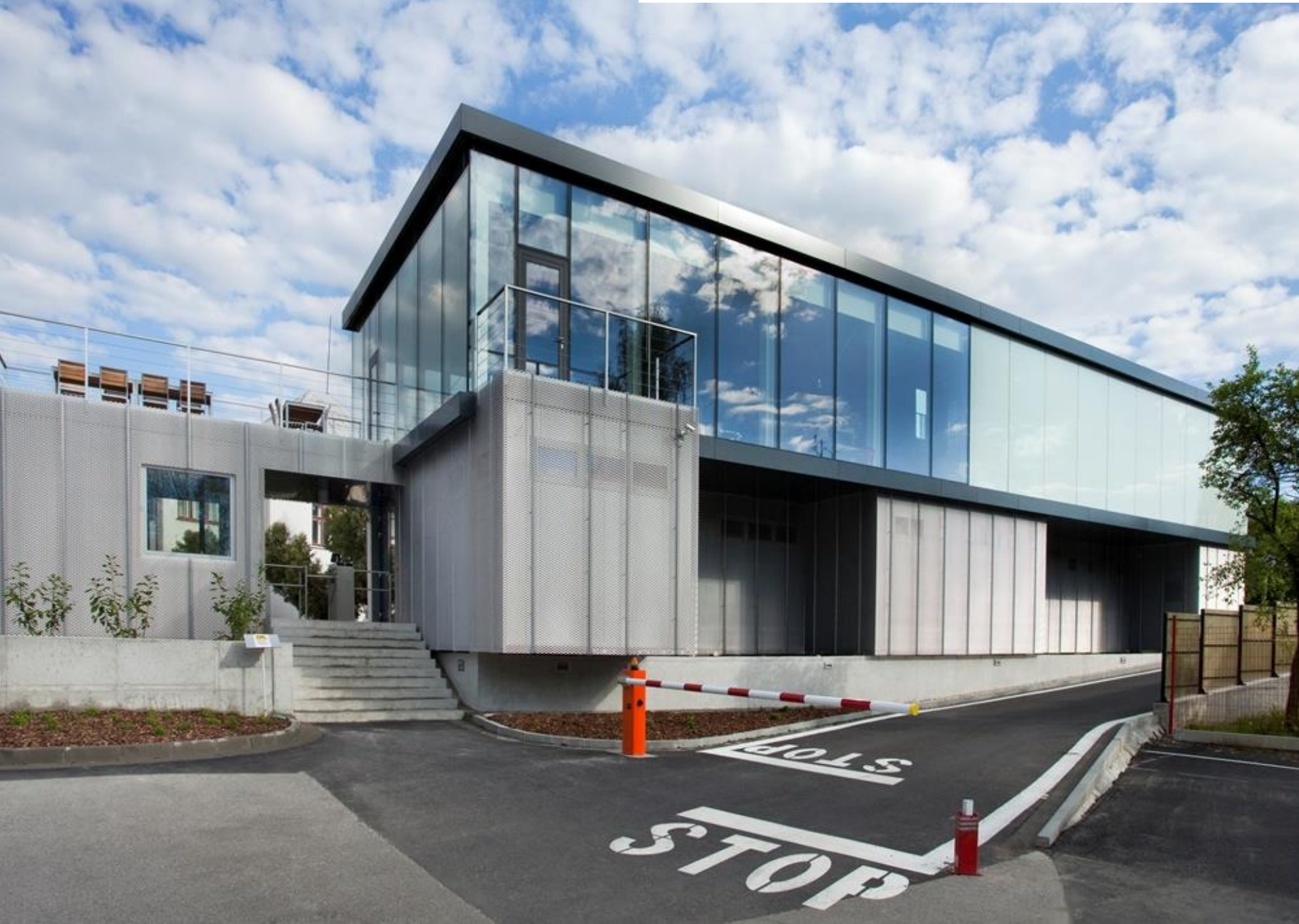
Závodní restaurace se šatnami - Vizovice
